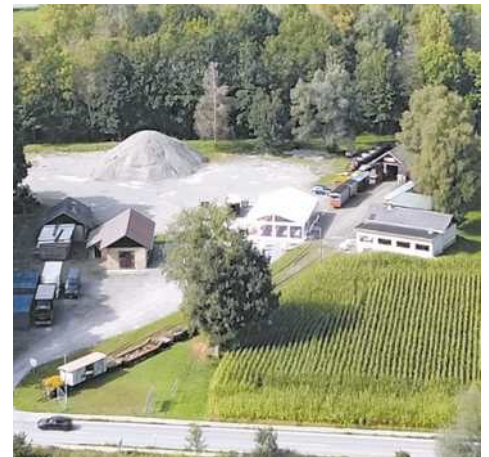
Luftbild Gelände Steinbruchseite vor dem Umbau
