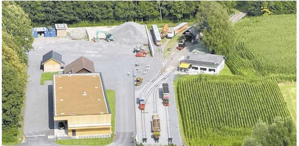
Luftbild Gelände Steinbruchseite nach dem Umbau
